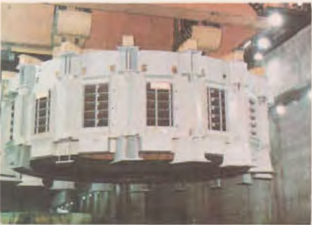
Unidad Generadora No. 7, 50 Hz. Descenso del estator del generador. 25/junio/86.
