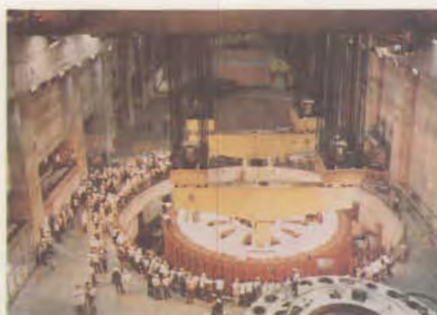
Unidad Generadora No. 5, 50 Hz. Descenso del rotor del generador. 12/noviembre/86.
