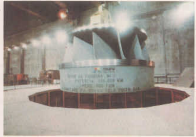
Unidad Generadora No. 6, 50 Hz. Descenso de la rueda de la turbina. 14/abril/86.
