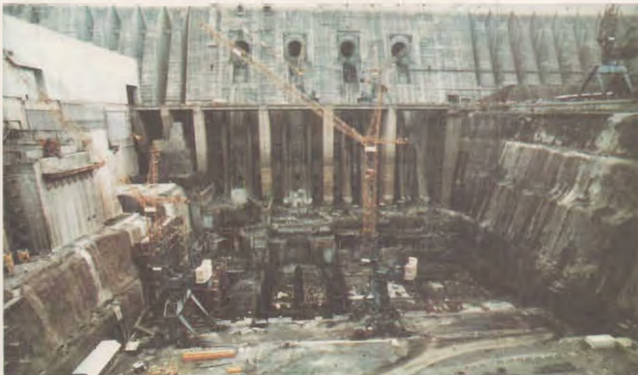
Con miras a la construcción de lo faltante en la casa de máquinas y estructuras anexas en el antiguo canal de desvío, en el ejercicio de 1986 fue realizada la excavación en roca, e iniciado en agosto el hormigonado, el cual deberá estar finalizado en 1989-90. La fotografía muestra algunos aspectos de esas actividades.
