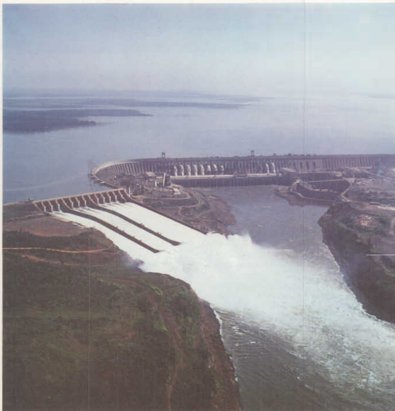
Vista de la central hidroeléctrica de Itaipú, en los inicios de 1987, con seis unidades generadoras en operación y nueve unidades en montaje, en diferentes etapas y, en construcción, el trecho de la casa de máquinas en el antiguo canal de desvío, para tres unidades más.
