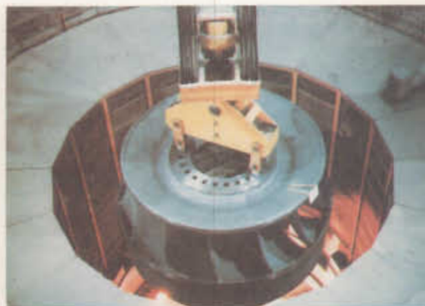
Unidad Generadora No. 7, 50 Hz. Descenso de la rueda de la turbina. 29/agosto/86.
