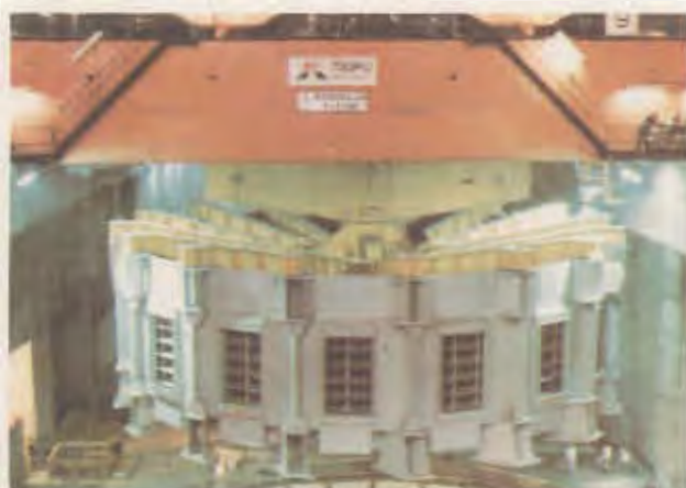
Unidad Generadora No. 6, 50 Hz. Descenso del estator del generador. 09/setiembre/86.
