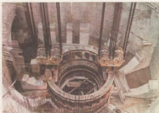
Unidad Generadora No. 11, 60 Hz. Descenso del pre-distribuidor de la turbina. 20/agosto/86.
