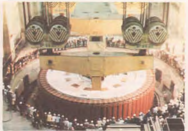
Unidad Generadora No. 14, 60 Hz. Descenso del rotor del generador. 04/julio/86.
