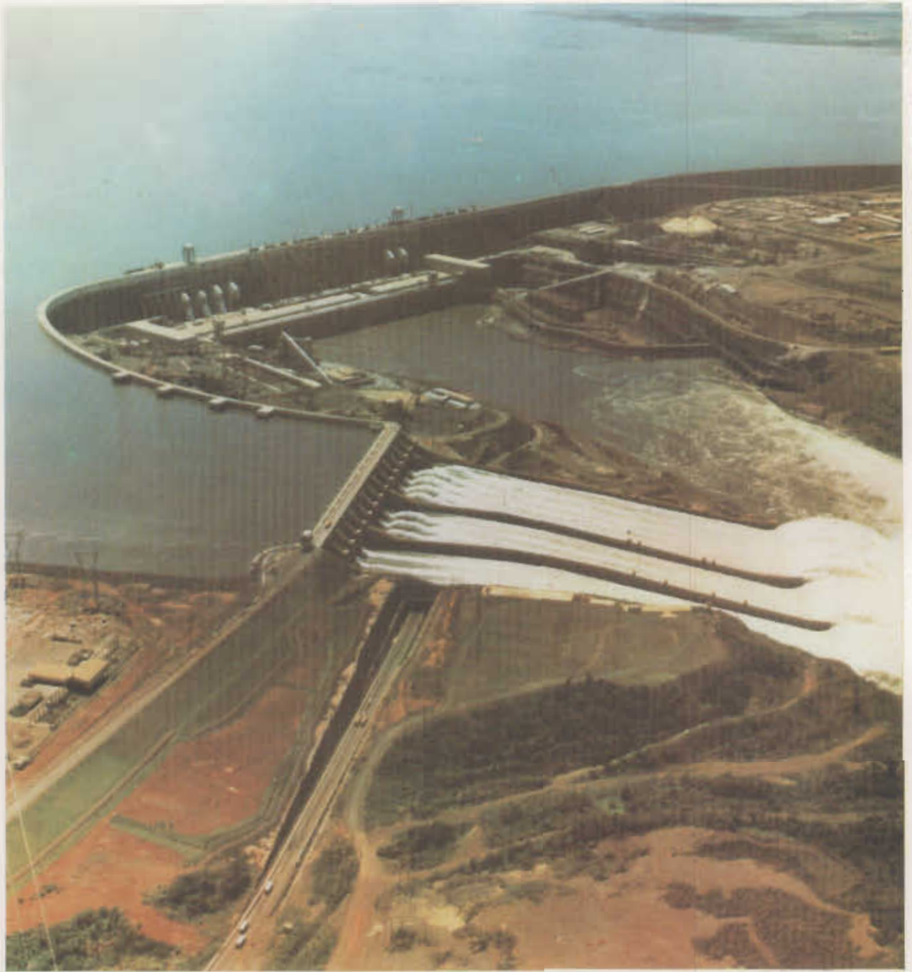
Vista de la central hidroeléctrica de Itaipú, a fines de 1984, teniendo dos unidades de 50 Hz en funcionamiento y seis unidades en proceso de montaje, en diferentes etapas.
