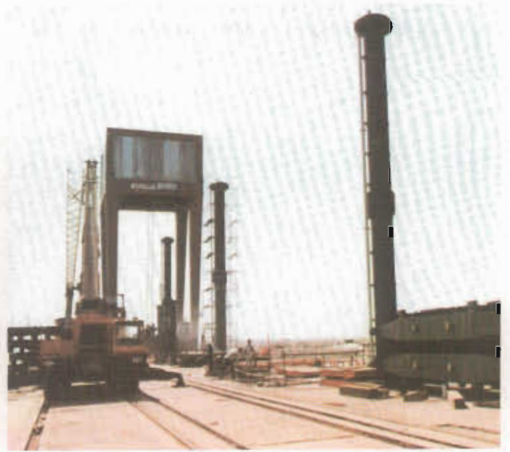
Servomotores de las tomas de agua n.º 1 y n.º 2 en montaje.
