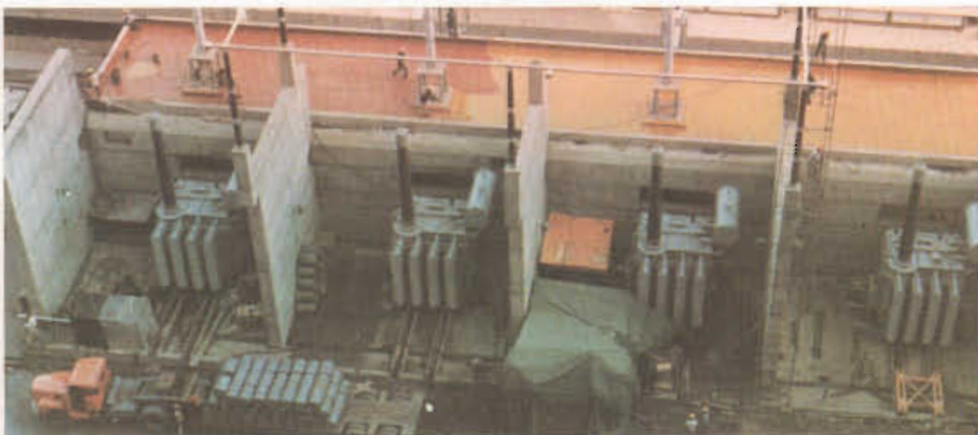
Banco n.º 1 (50 Hz) de los transformadores principales de los servicios auxiliares de la casa de máquinas, en fase final de montaje
