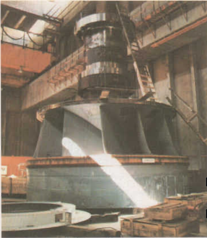
La rueda y respectivo eje de una de las turbinas siendo acoplados en la Central de Itaipú.
