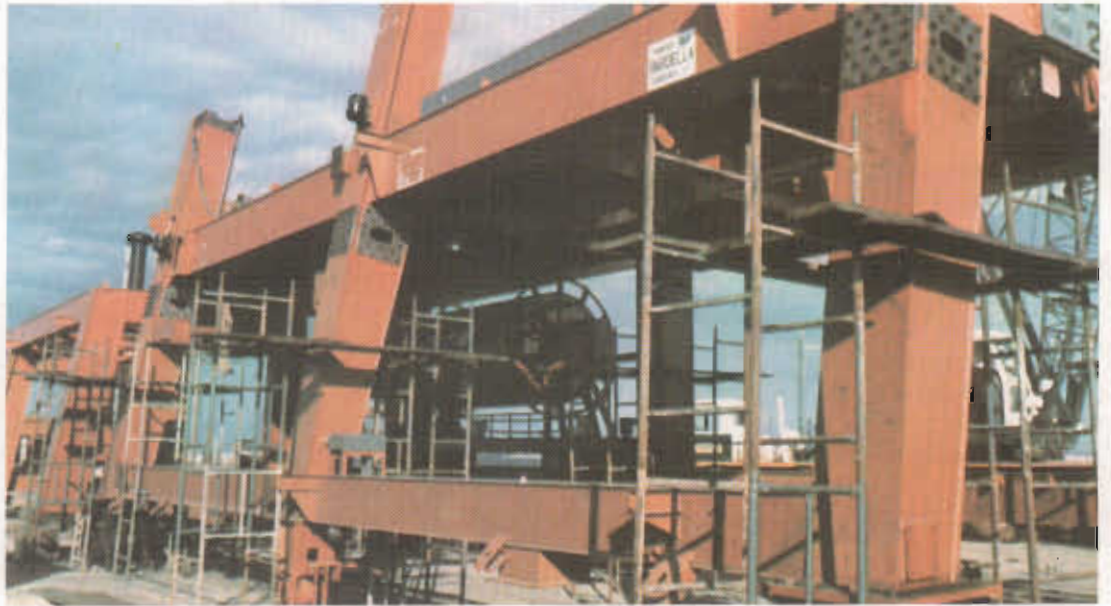
Grúa limpia rejas n.º 1 en montaje.
